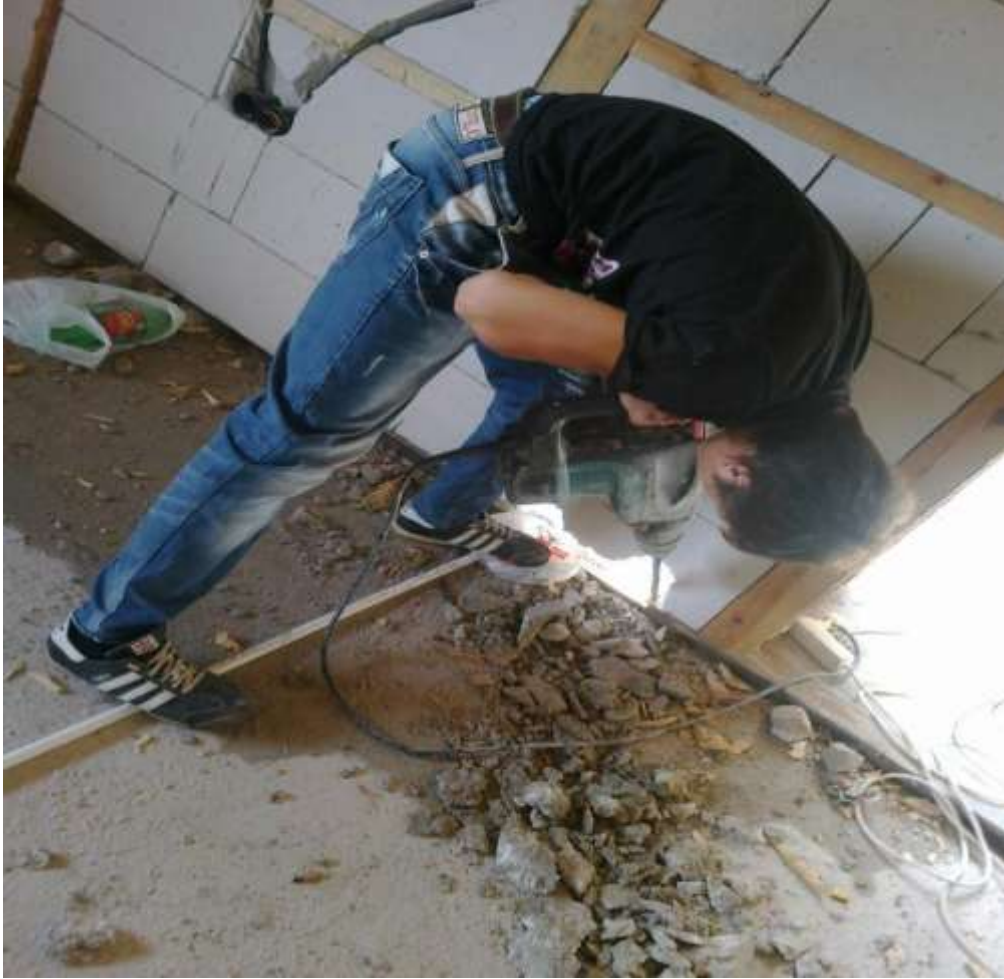
ğekil-25 Teras kat su gideri döÇemesi kırılması
