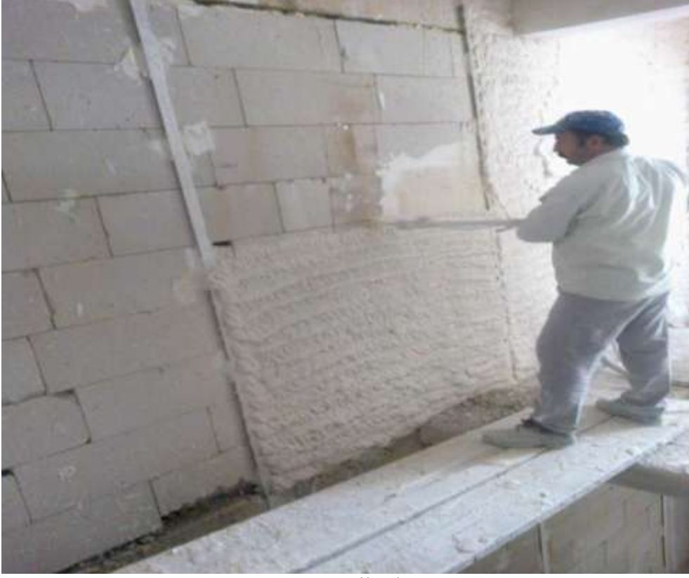
Şekil-7 Pompa ile alçı yapımı
