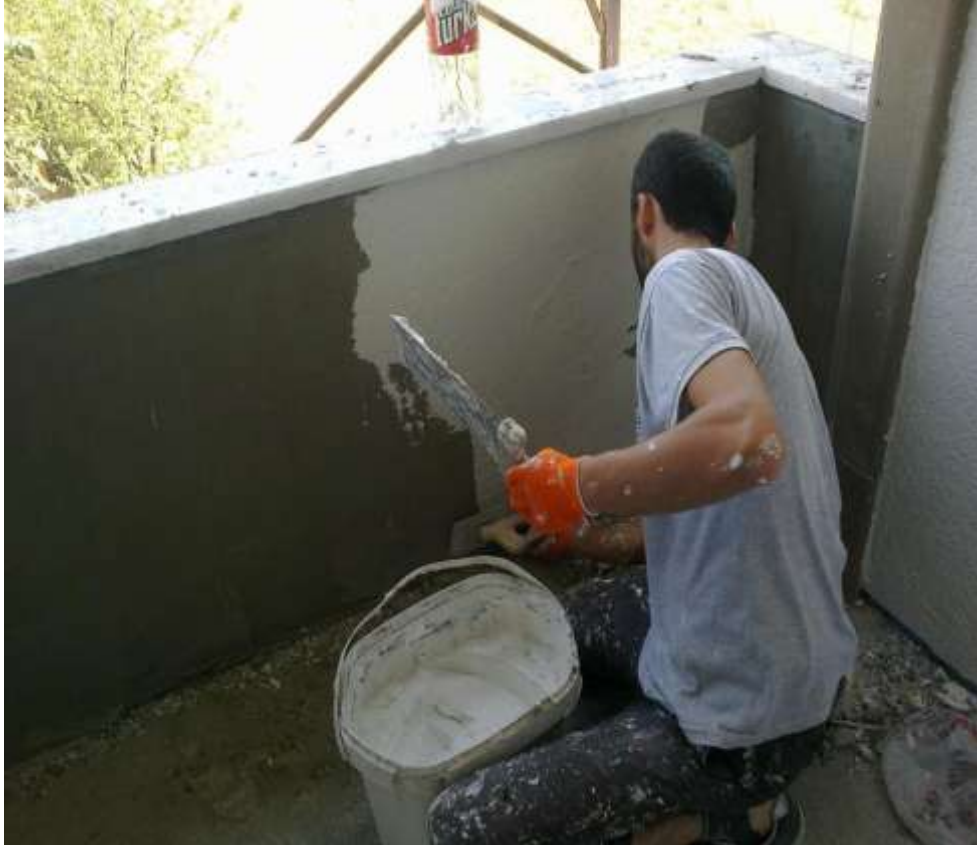
ęekil-11 Dekoratif sıva düzeltilmesi
