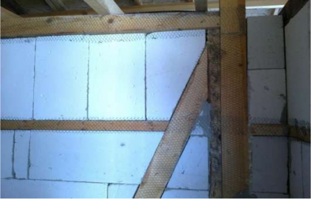
ğekil-18 Rabitz tel yapıÇtırılması
