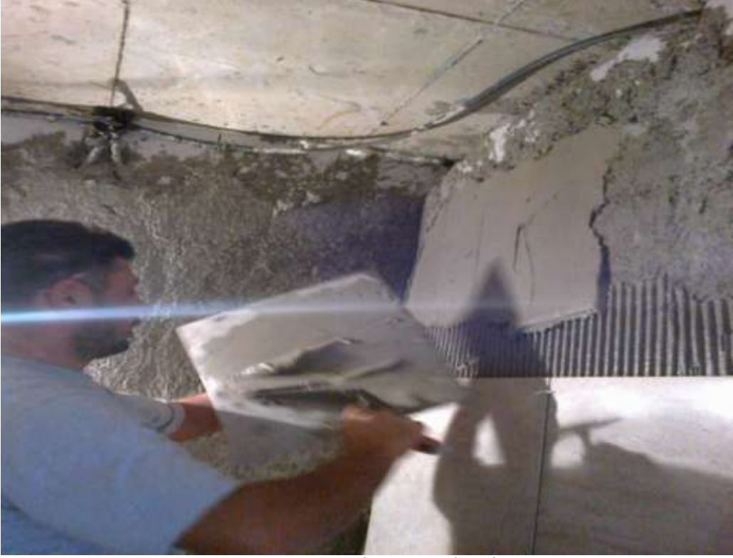
ğekil-14Harcın duvara sürülmesi
