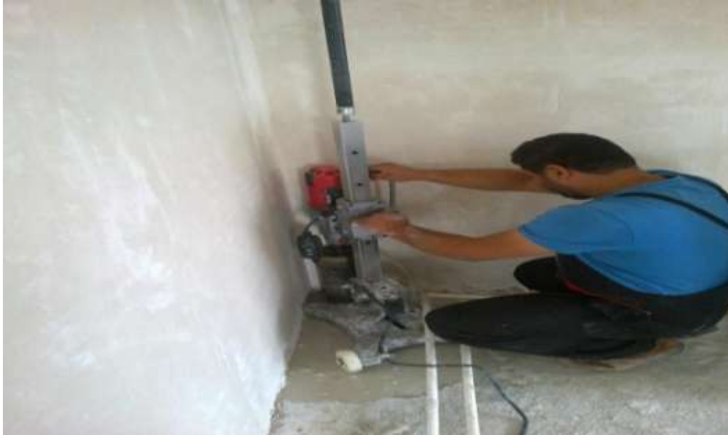
ėekil-21 Karot makinesi ile dđđeme delinmesi
