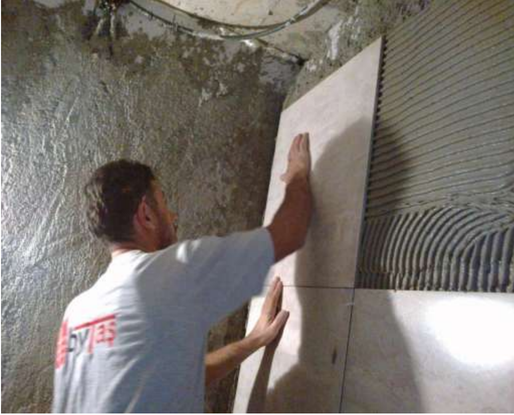
Şekil-16 Fayansın yapıÇtırılması
