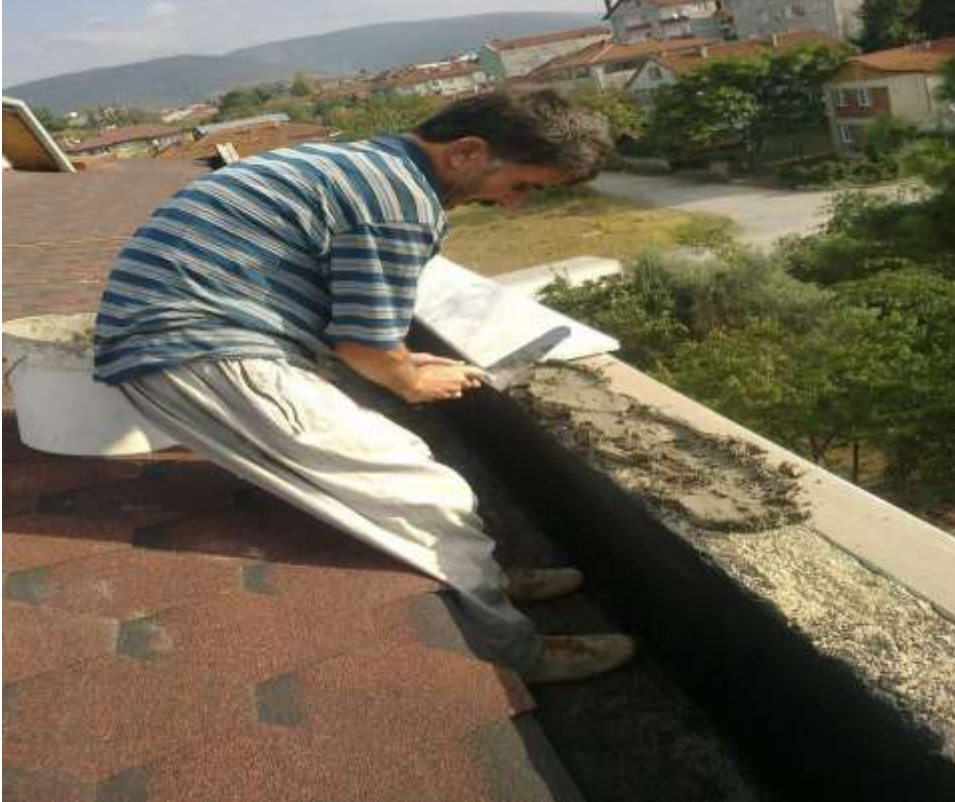
ğekil-36 Harcın yüzeye sürülmesi
