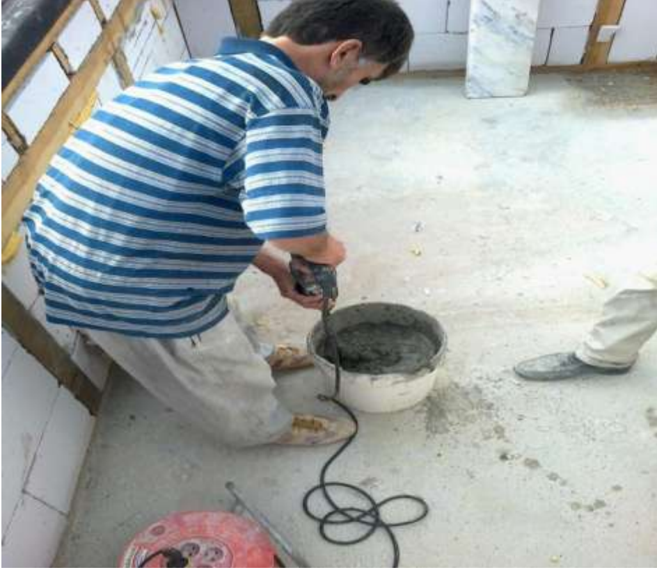
ğekil-35 Mermer harcının hazırlanması
