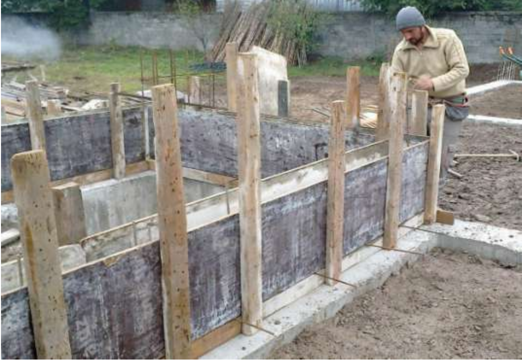
ğekil-62 Perde kalıbaçiroz atımı
