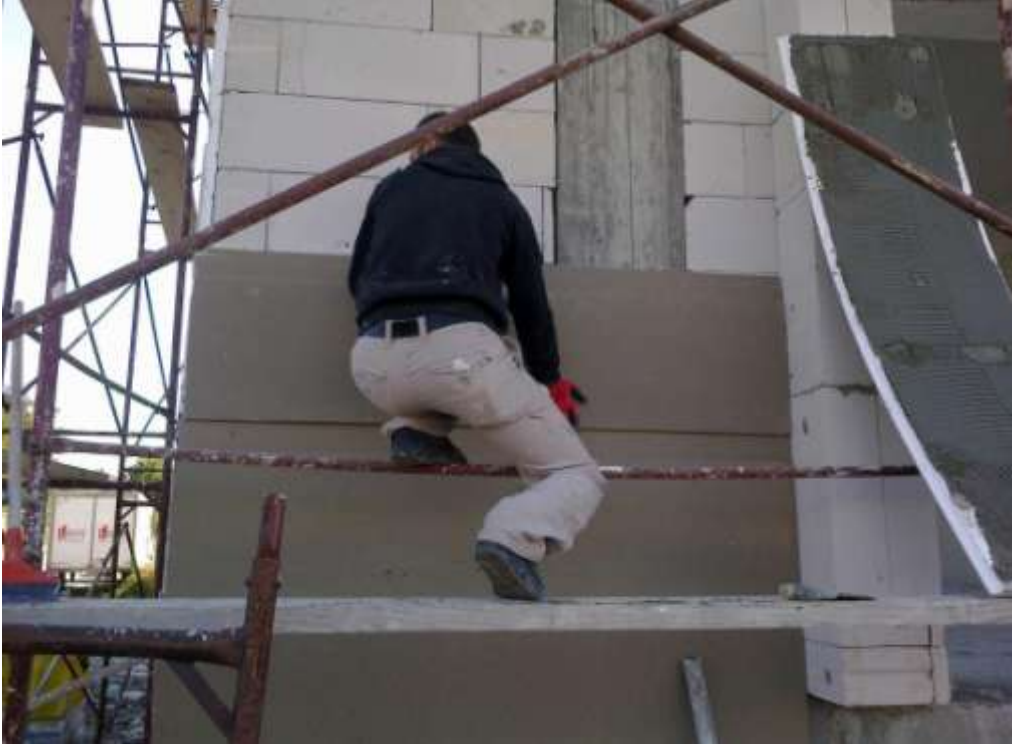
ęekil-28 Fugalı mantolaması
