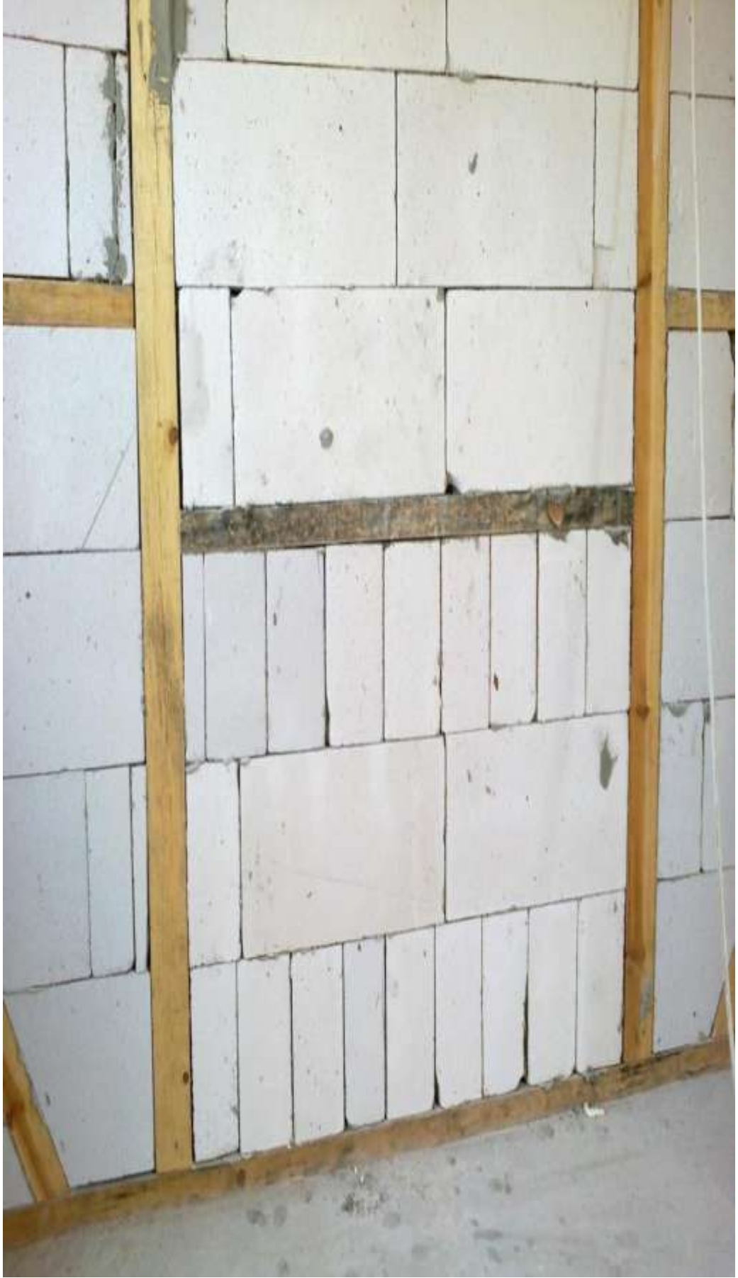
ğekil-1 Gaz beton duvar örümü
