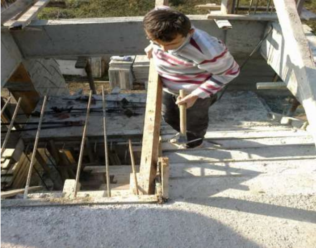
ğekil-79 Merdiven kalıp sökümü
