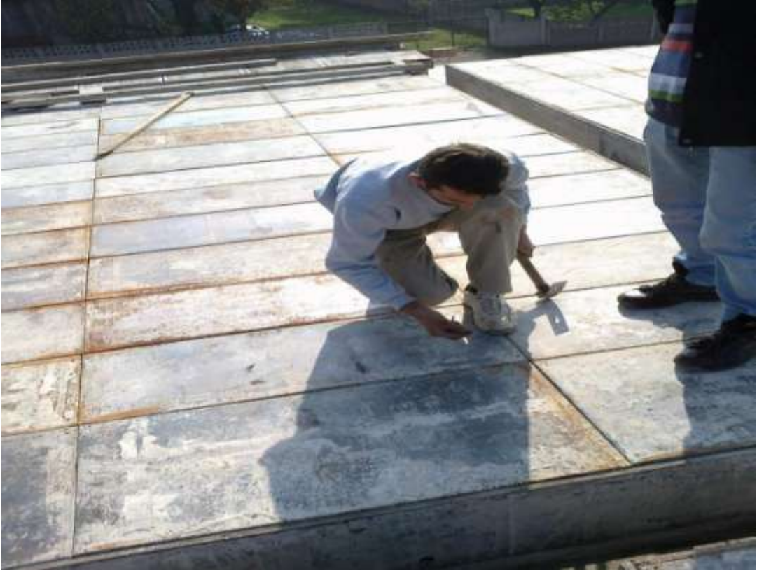
ğekil-72 Pano döÇemesine çiviçakımı
