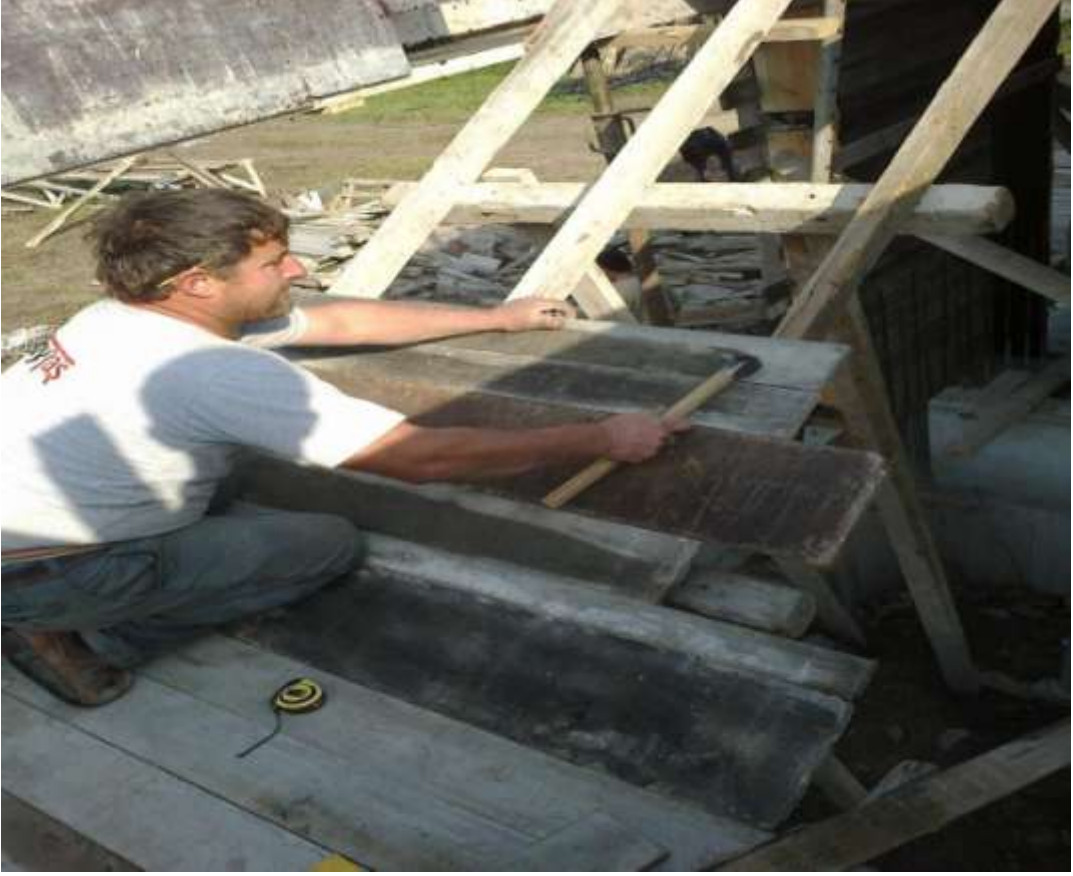
ğekil-75 Basamak kalıp yapımı
