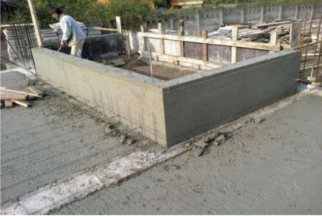
şekil-64 Perdedeki çirozların çıkarılması
