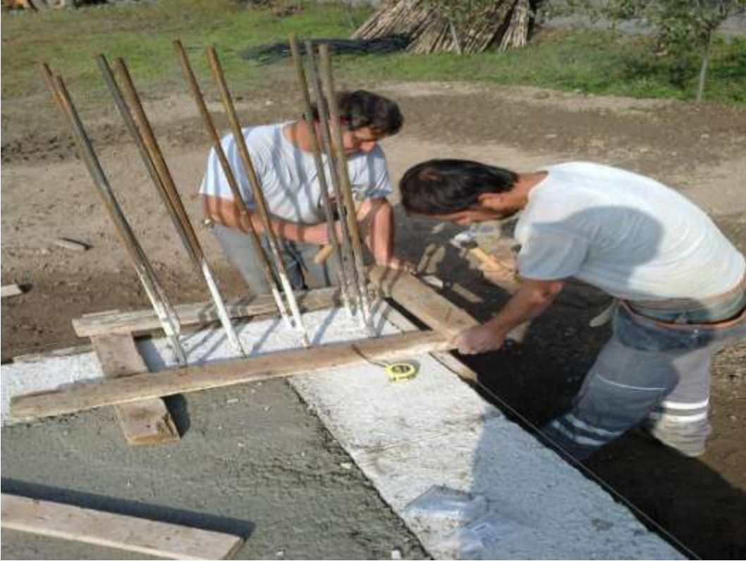
ğekil-66 Kolon akslarının çakılması
