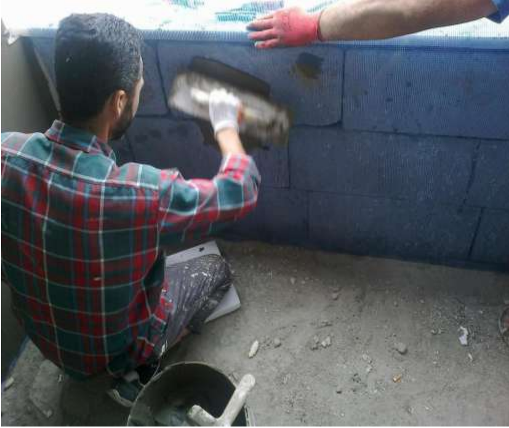
ğekil-32 File yapıřtırılması
