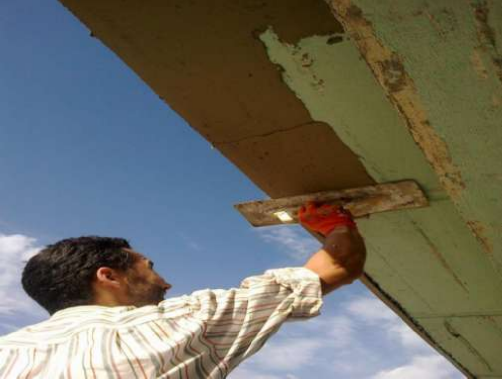
Şekil-45 Yapıdırıcı sıva yapımı
