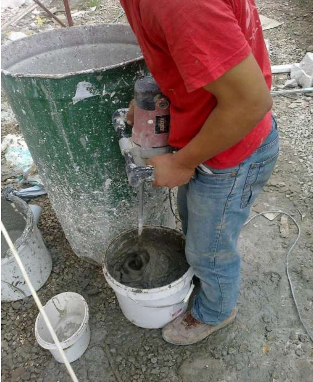
ęekil-31 Harç hazırlanması
