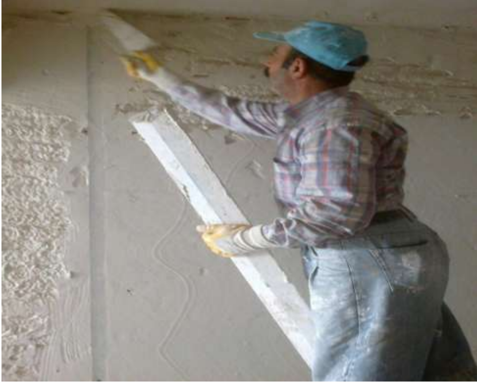
Şekil-8 Mala ile alçı düzeltilmesi
