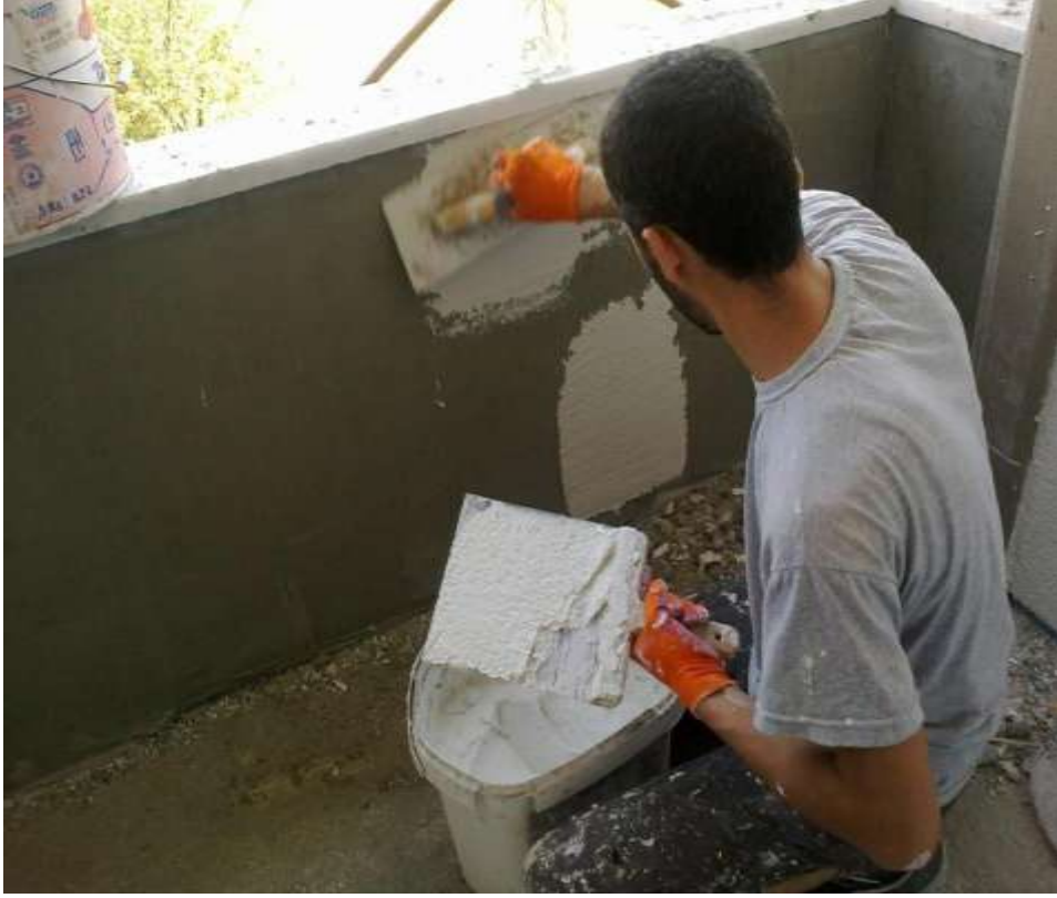
ęekil-10 Dekoratif sıva sürülmesi
