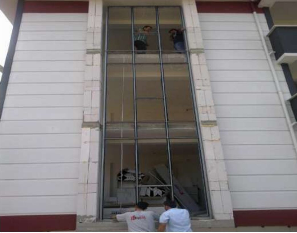
ġekil-41 Dođramanın takılması
