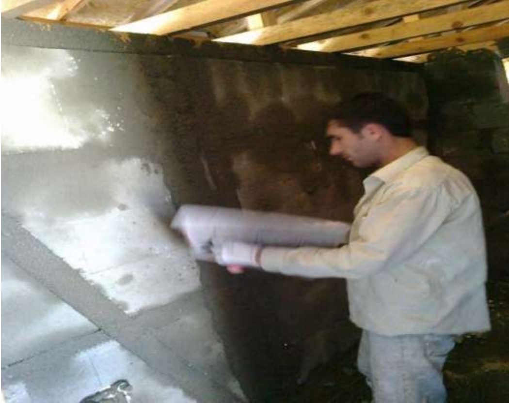
ğekil-19 Anolarını yapılması
