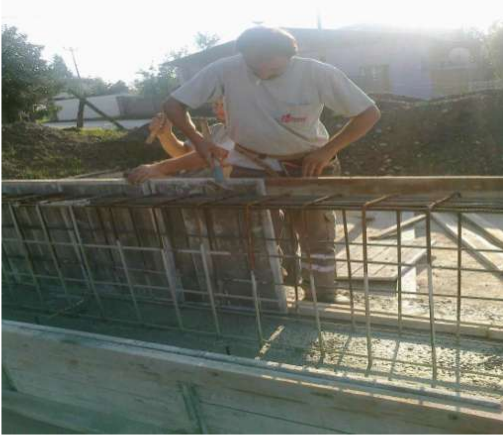
ekil-56 Temel kiri kanat akılması
