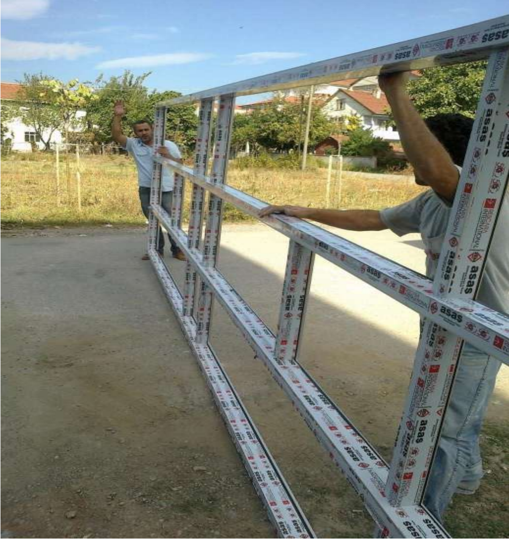
Şekil-40 Doğramanın kaldırılması
