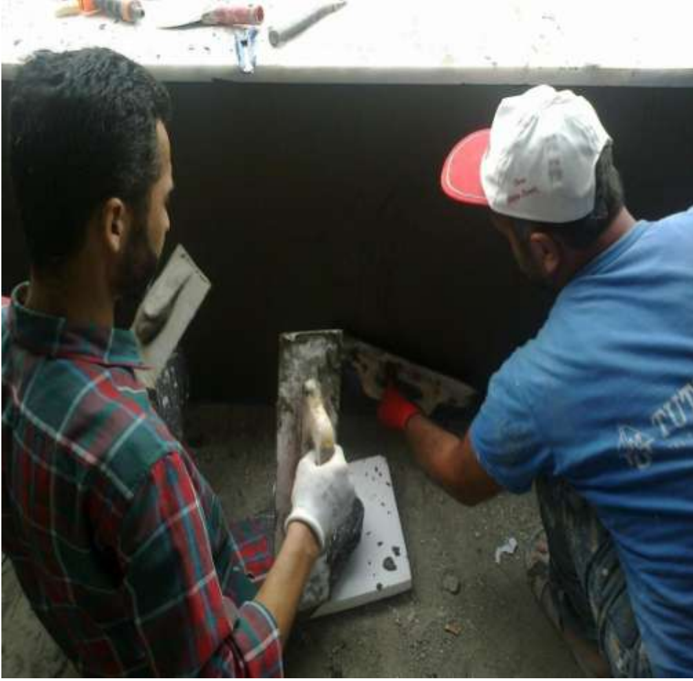
Şekil-34 Yapıştırıcı sıvanın düzeltilmesi
