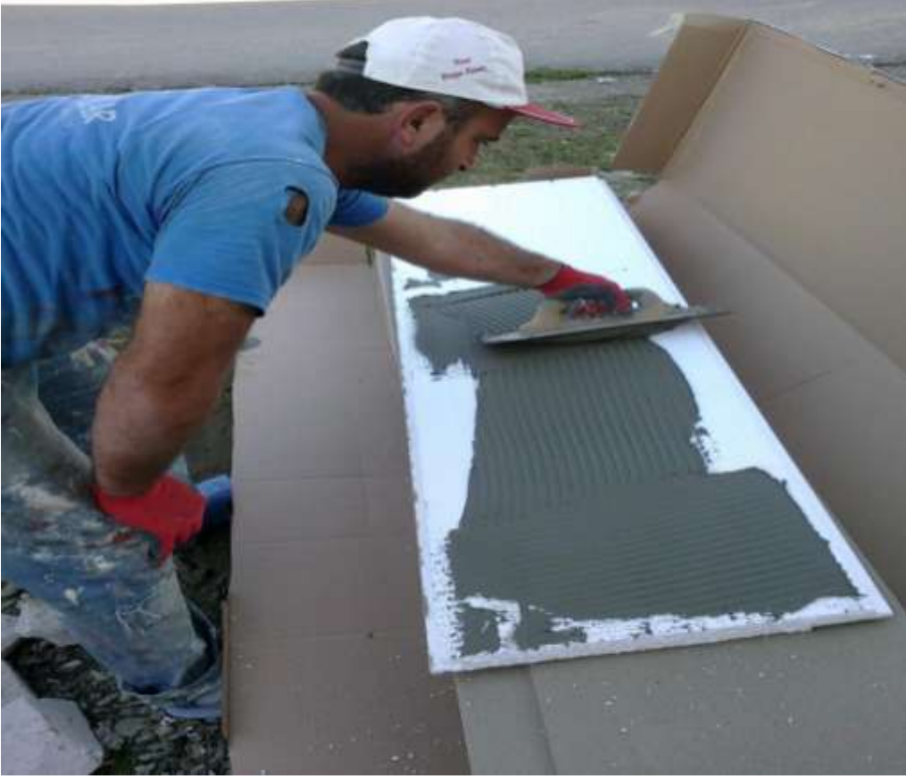
ęekil-27 Fugalı yapıřtırıcı taraklanması
