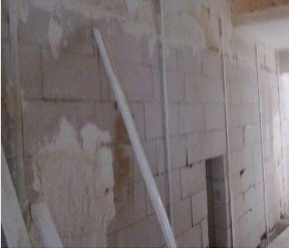
şekil-6 Anoların yapıştırılması
