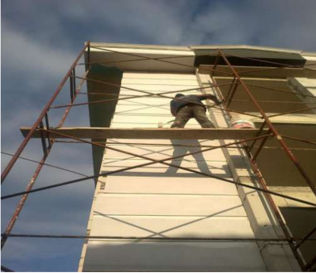
Şekil-39 Dış cephe boya yapımı
