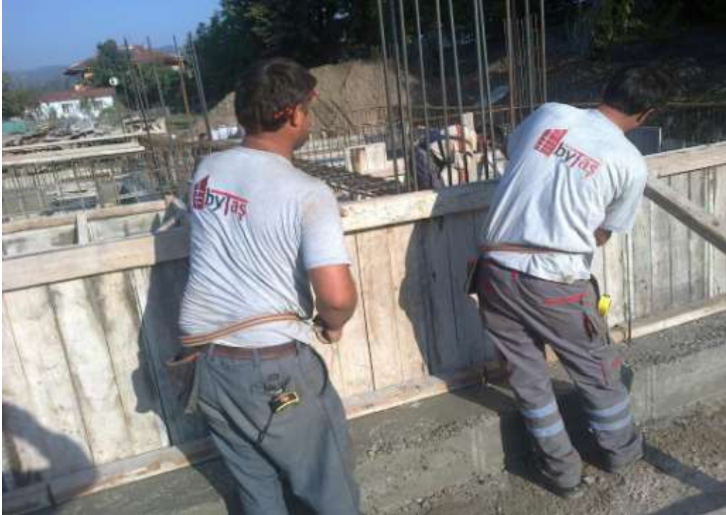
ekil-57 Kanatlara destek vurulması
