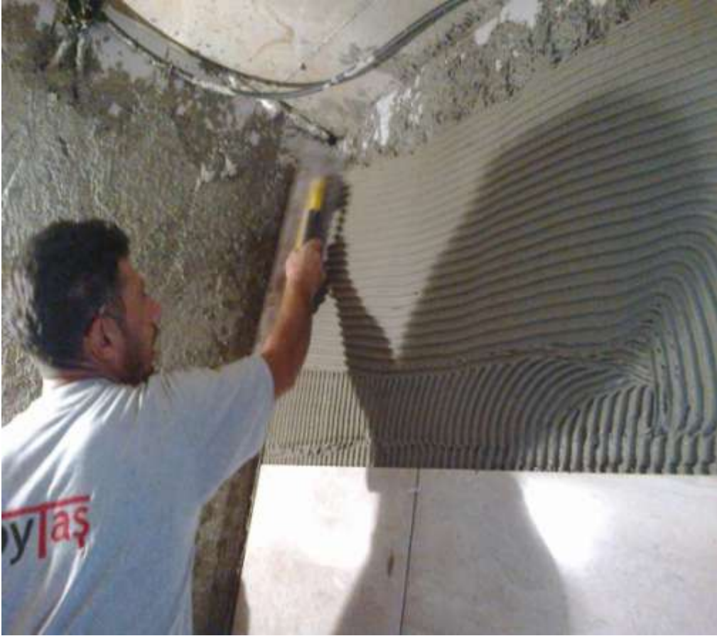
ğekil-15 Fayans harcının taraklanması
