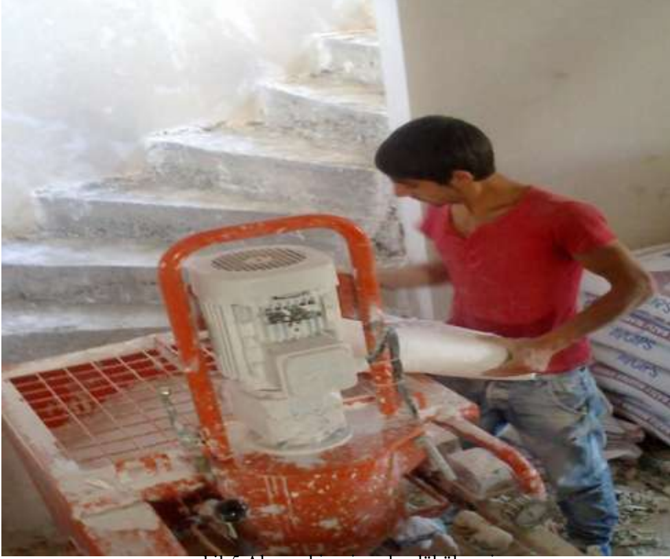
şekil-5 Alçı makinesine alçı dökülmesi
