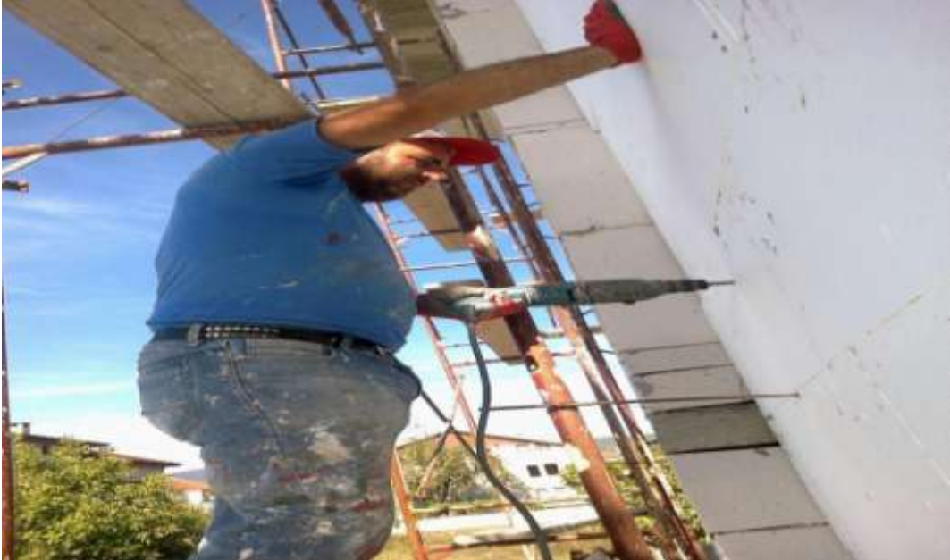
ęekil-29 Köpük için duvar delinmesi
