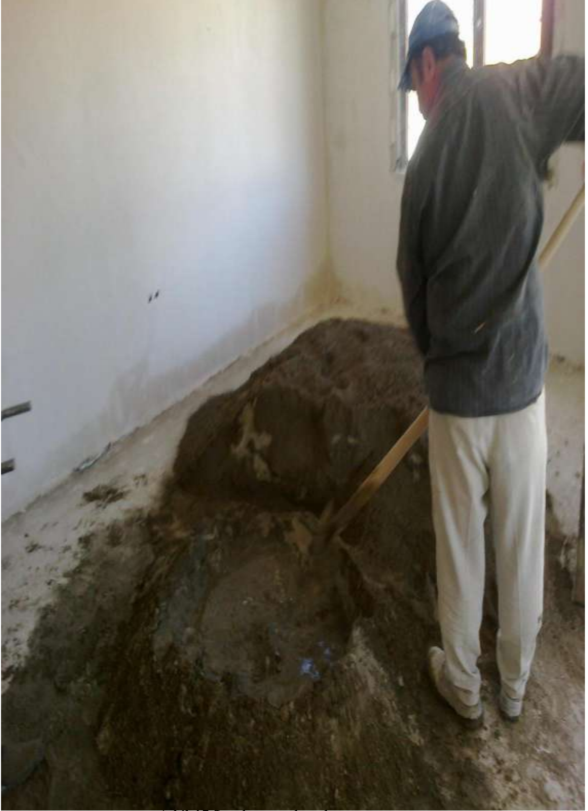
Şekil-17 Sıva harcının hazırlanması
