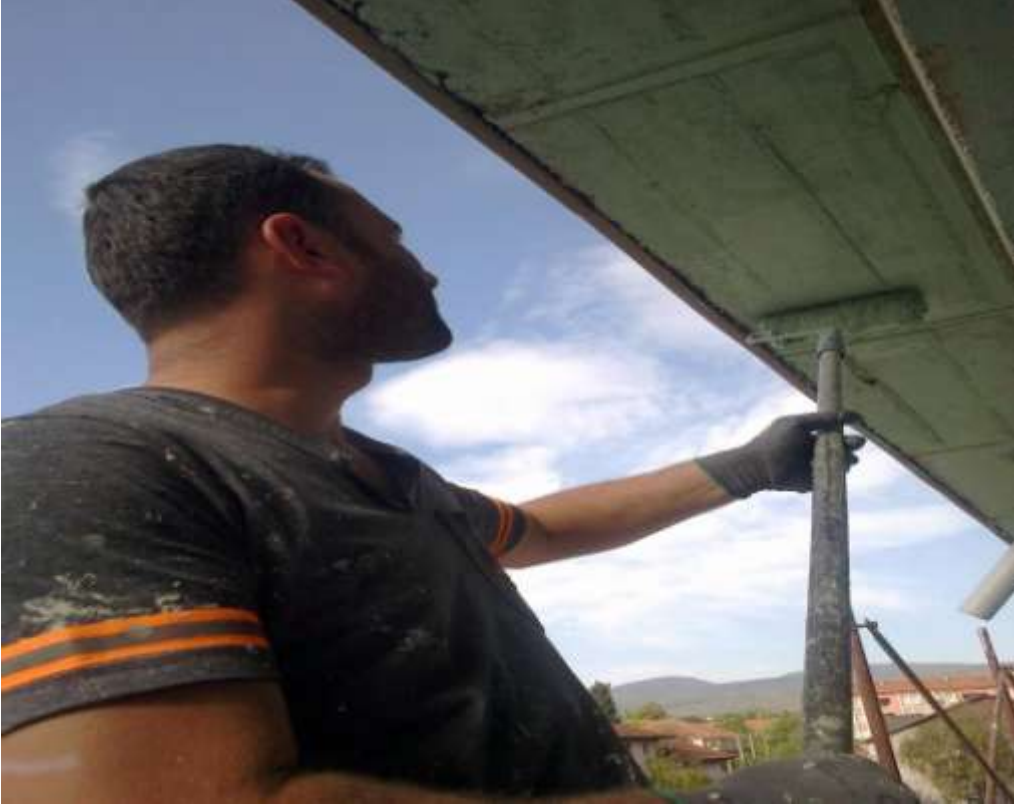
Şekil-44 Betokontak sürümü
