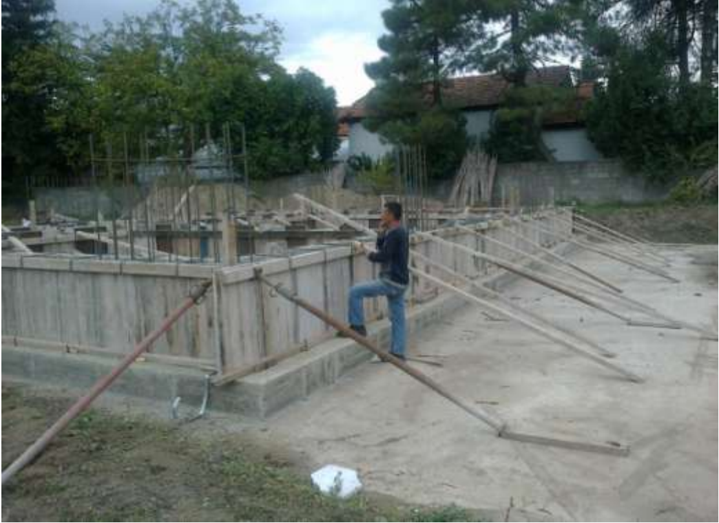
ğekil-59 Temel kalıbına destekler vurulması
