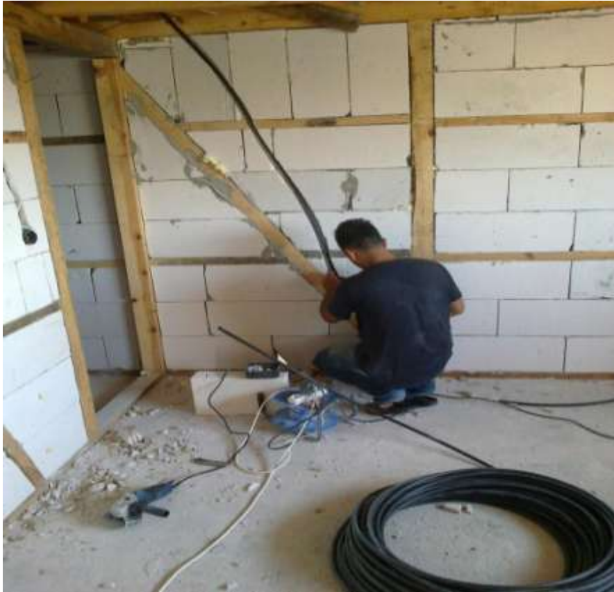
Şekil-12 Elektrik kabloları döşemesi
