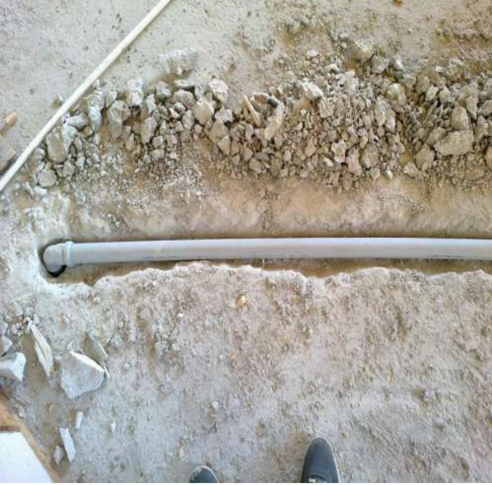
Şekil-26 Teras kat su gideri boru döşemesi
