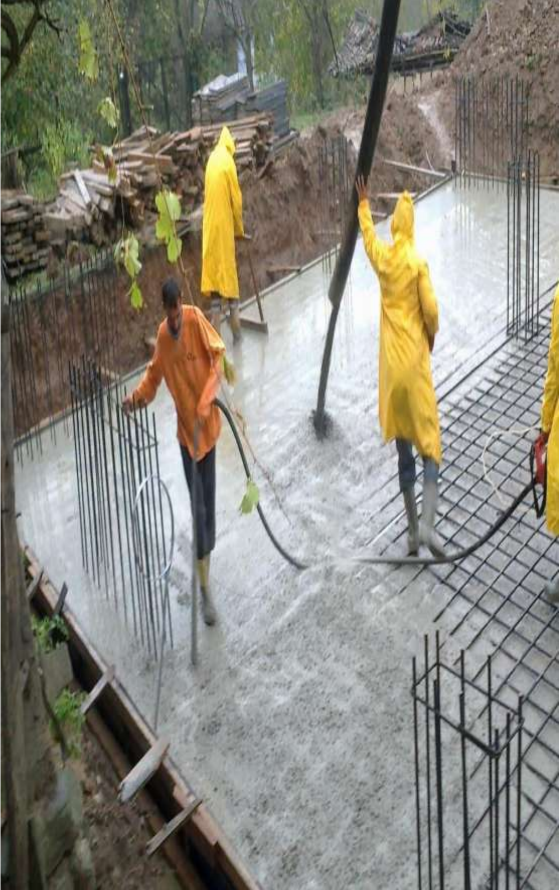
ğekil-89 Masterla beton düzeltilmesi
