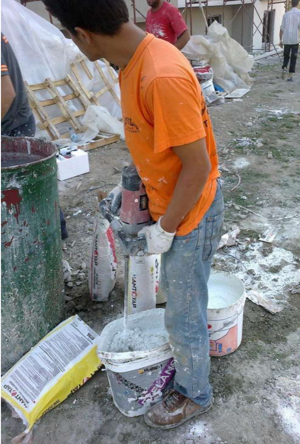
ğekil-9 Dekoratif sıva harç yapımı
