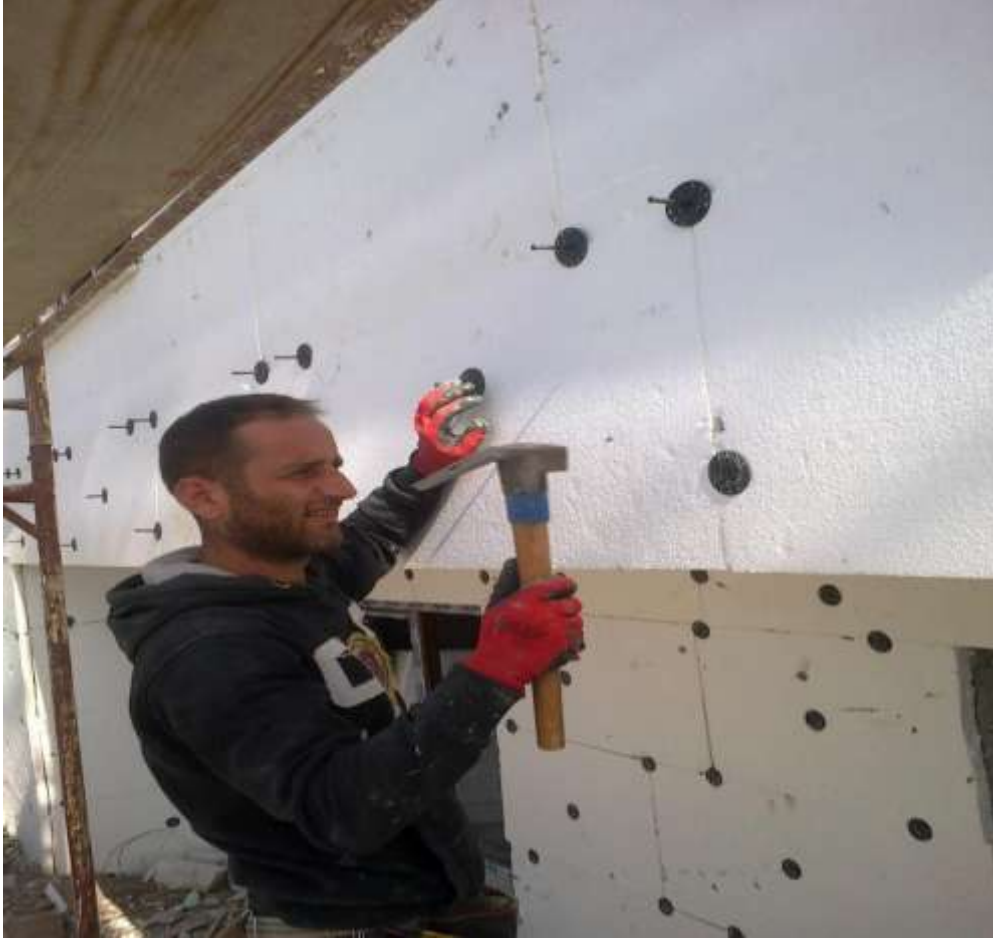
Şekil-30 K p klere d bel atılması
