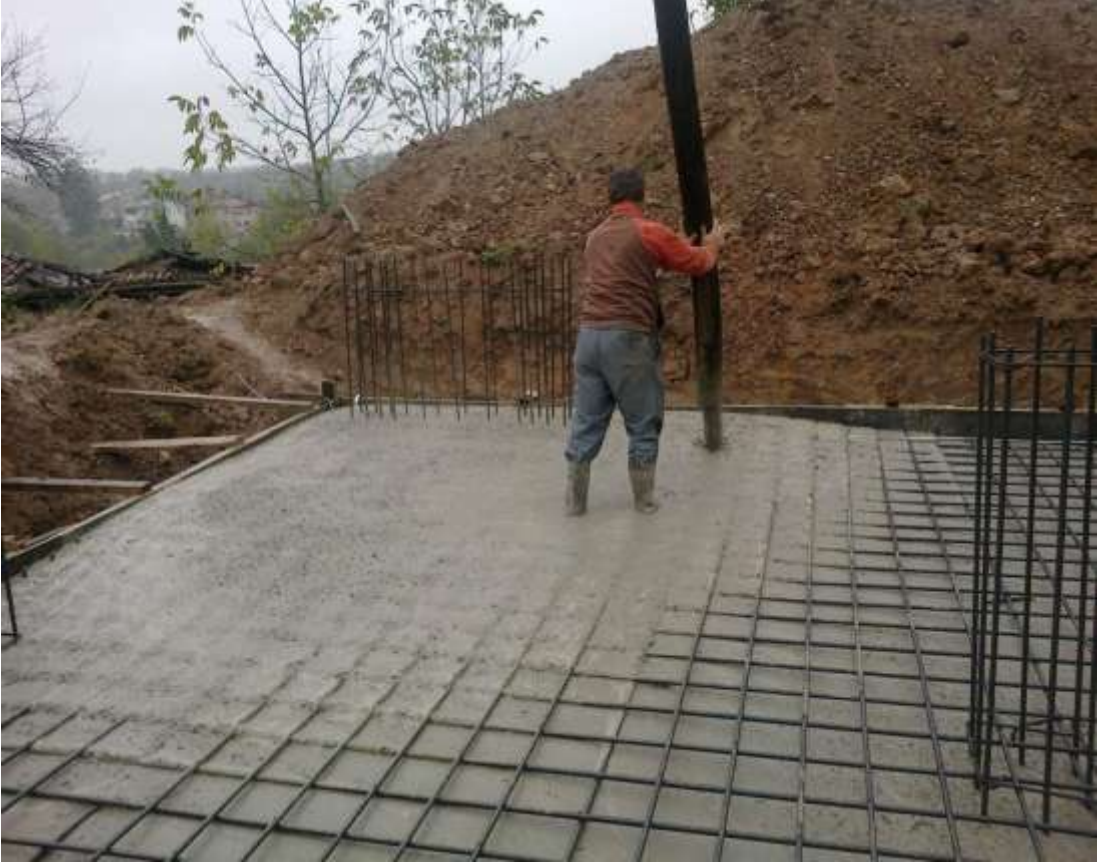
ekil-87 Pompa ile beton d k m 
