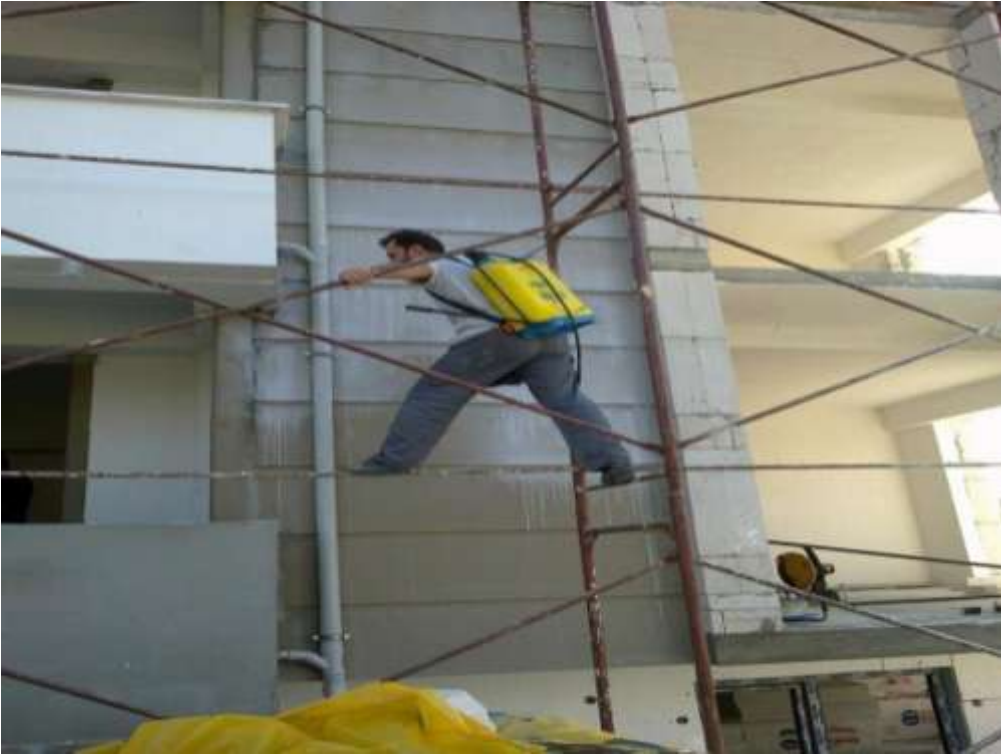
Şekil-38 Yüzey astarlama
