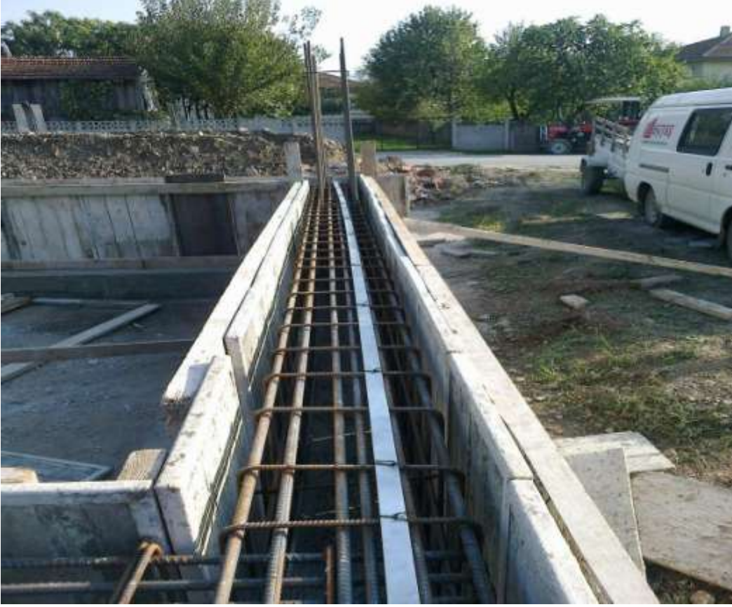
ğekil-58 Kanatların çift taraflı yapımı
