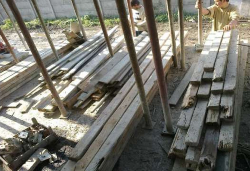
ğekil-81 Kalıpları istiflenmesi
