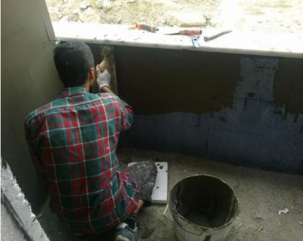
ğekil-33 Yapıřtırıcı sıva sürülmesi
