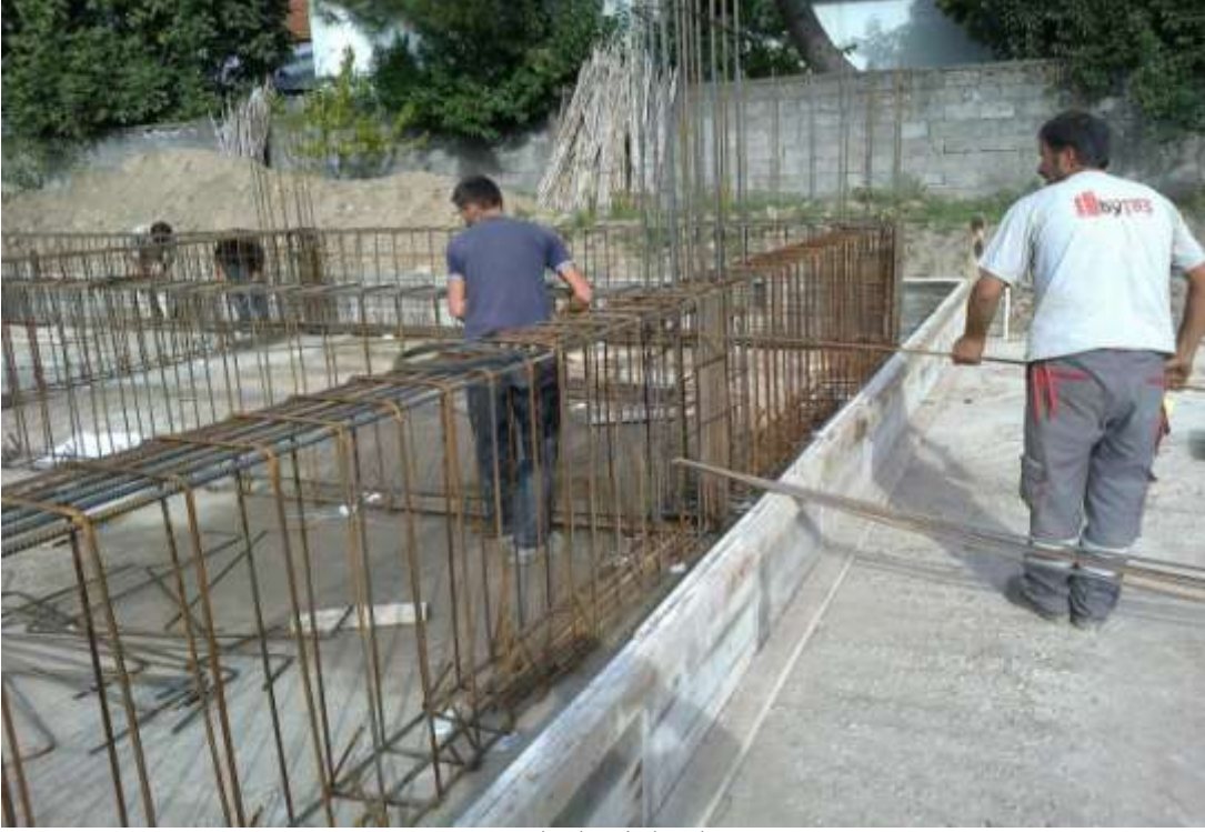
ğekil-52 Gövde demir bağlanması
