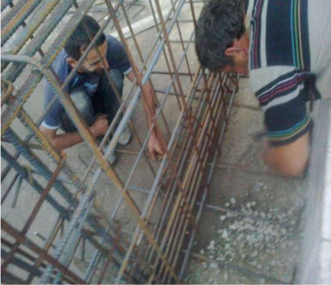
ğekil-53 Izgara demirlerinin bağlanması
