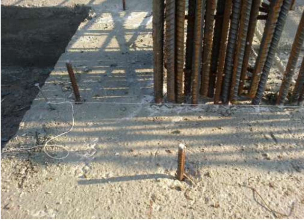
ğekil-54 Aks noktalarına ip çekilmesi
