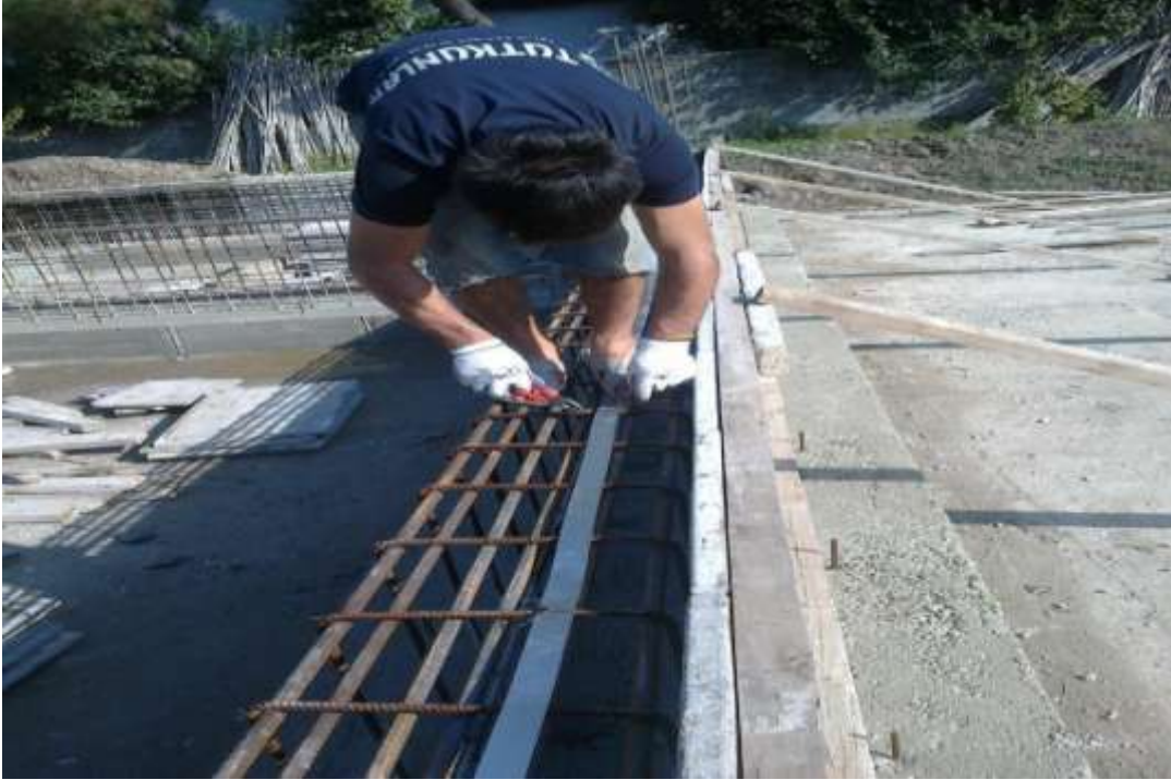
ğekil-86 Levhaların donatıya bağlanması
