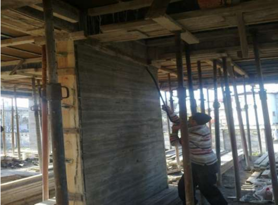
Şekil-77 Kolon kanat sökümü
