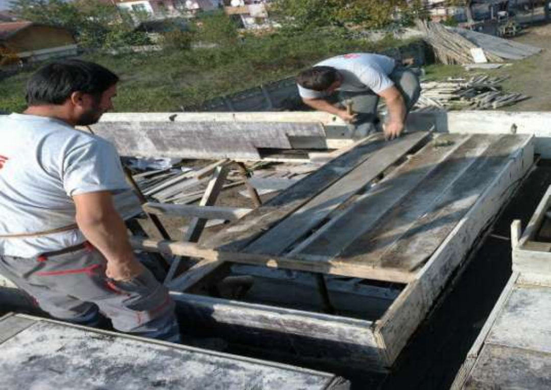
ğekil-76 Üst kat sahanlık kalıp yapımı
