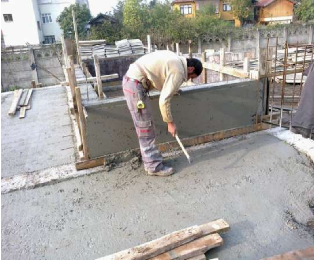
ğekil-63 Perde kanat sökümü
