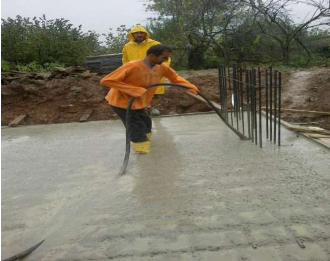
ęekil-88 Vibratör kullanımı
