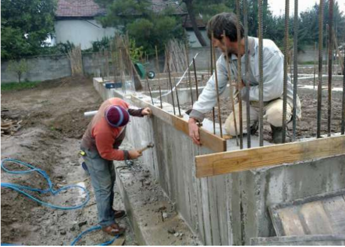
Şekil-60 Perde kanat yapımı
