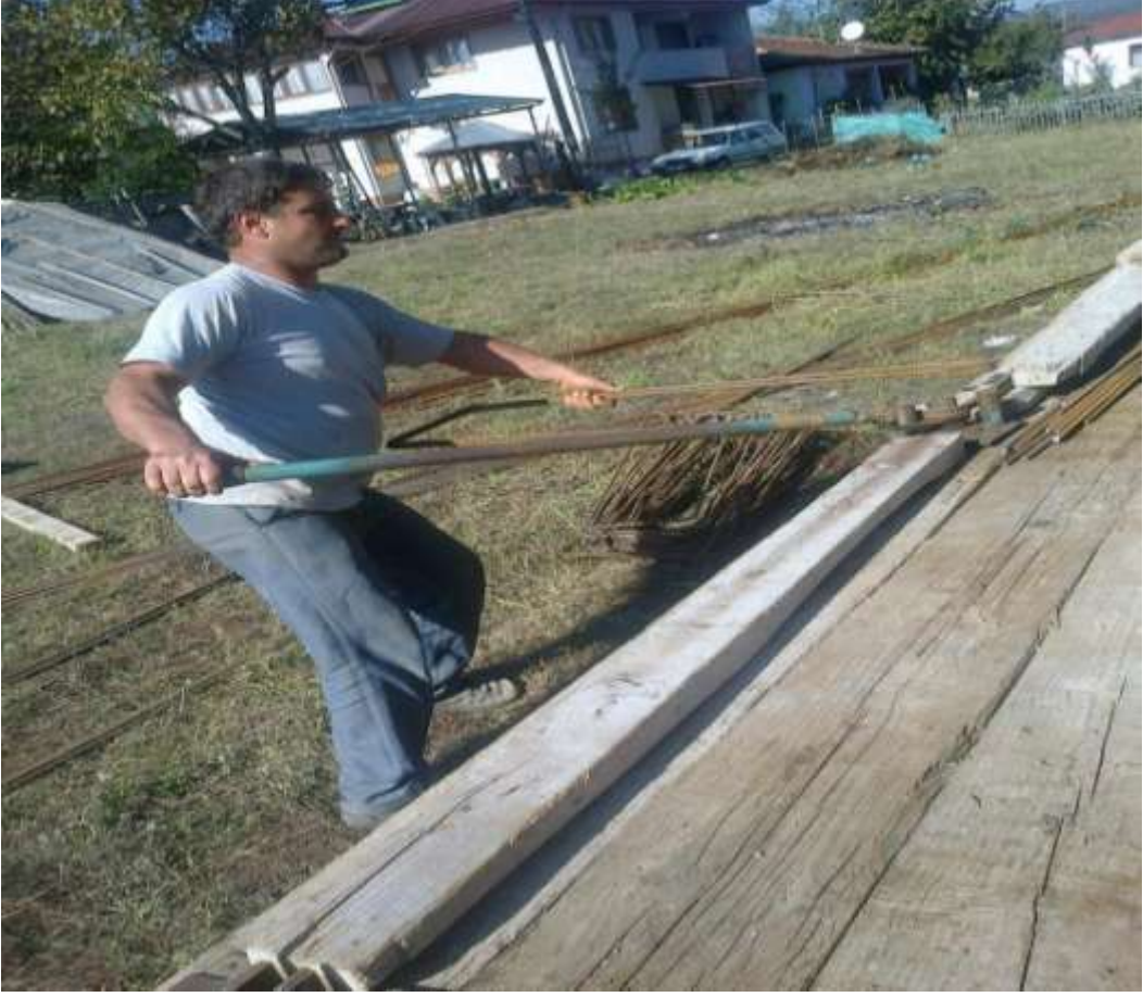
ğekil-47 Etriye bükülmesi
