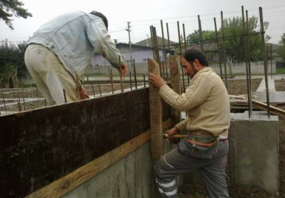
Şekil-61 Perde kanatlara destek yapımı
