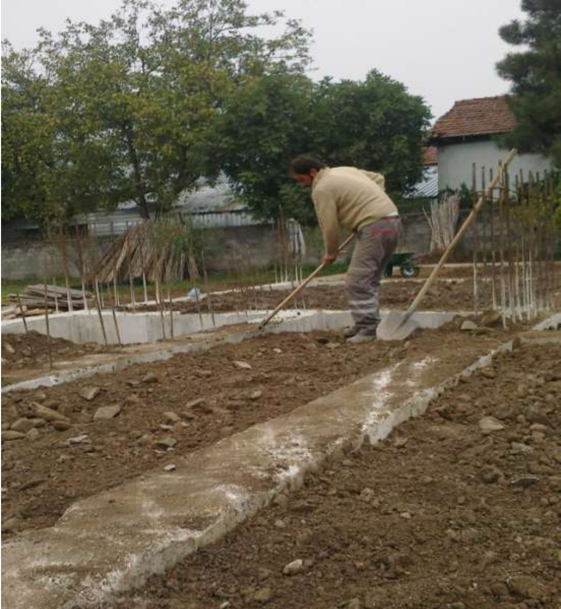
şekil-82 Dolgu düzeltilmesi
