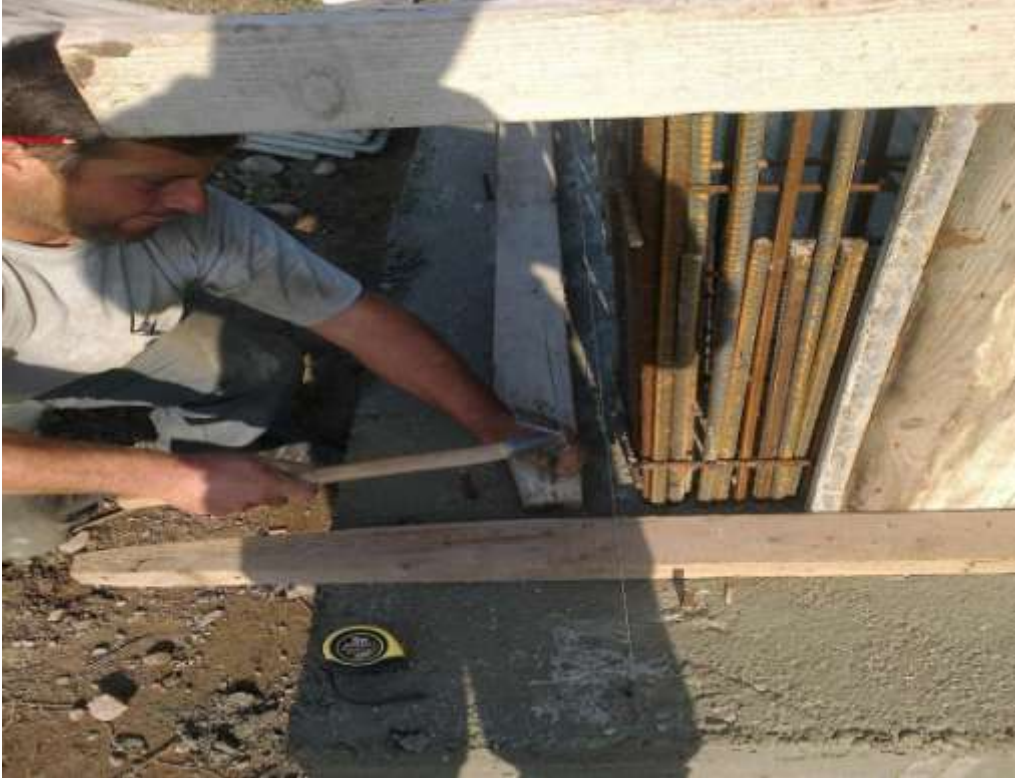
ğekil-55 Aks noktalarına 5*10 vurulması
