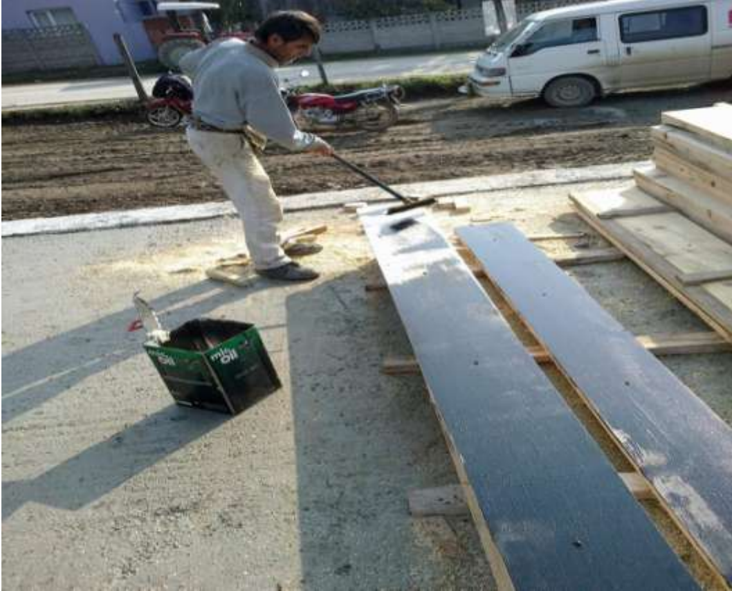
ğekil-67 Yanak kalıplarını yağlanması
