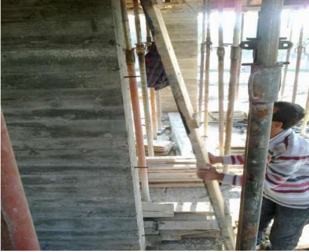
ğekil-78 Kolon yanaklarının sökümü
