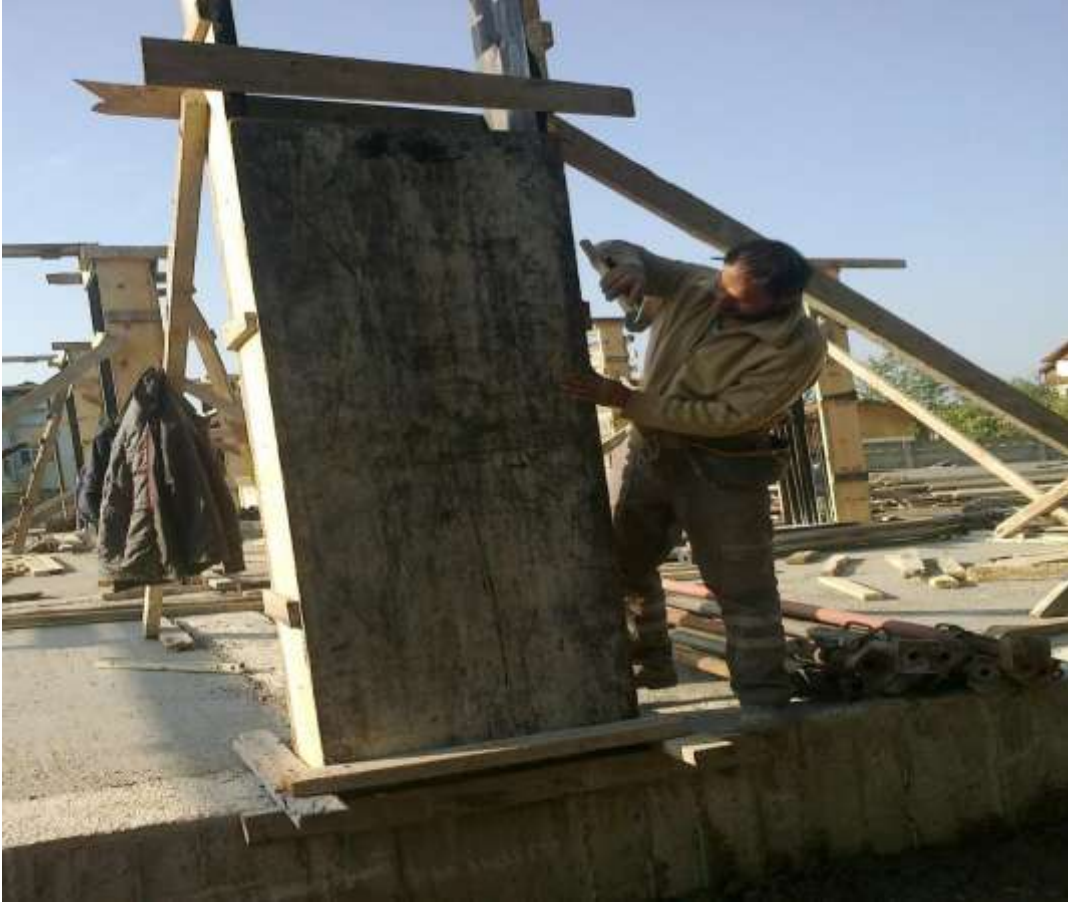
ğekil-70 Kolon kanat çakılması
