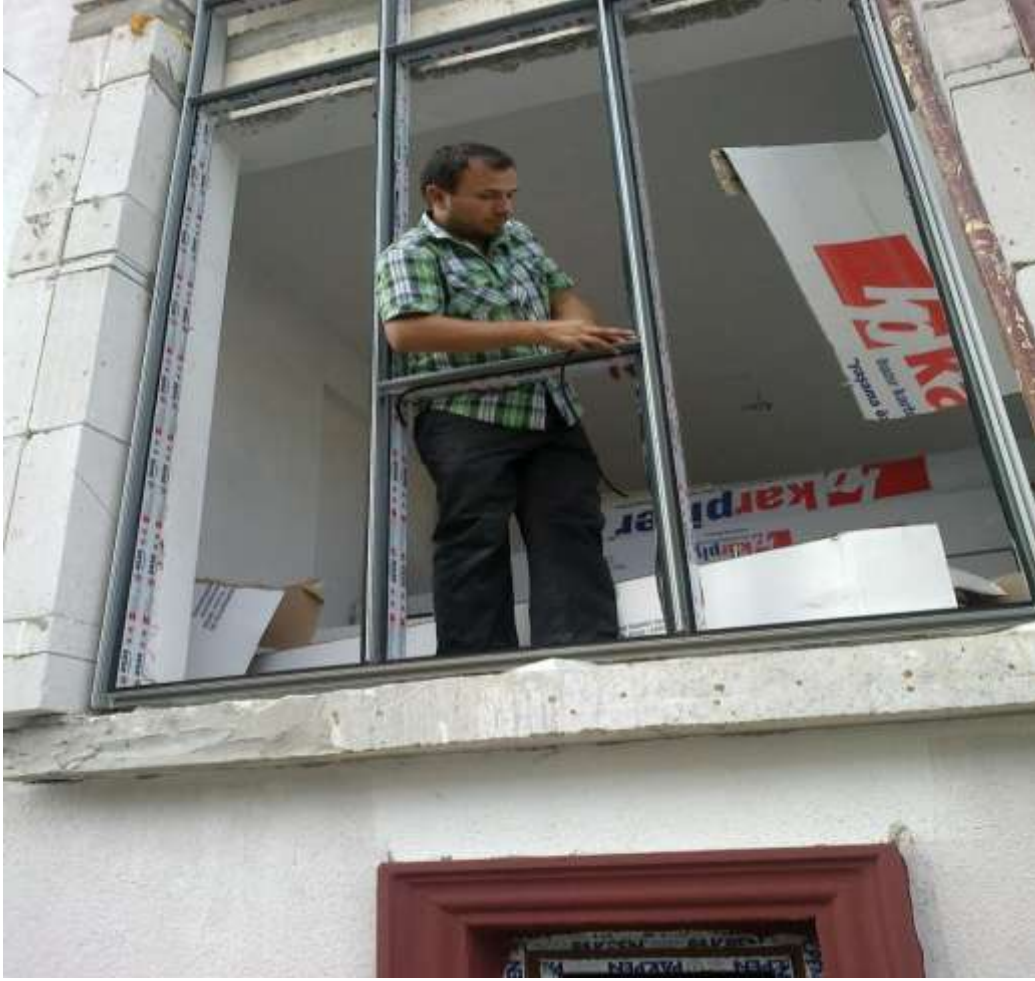
ğekil-43 Doğrama filtrelerinin takılması
