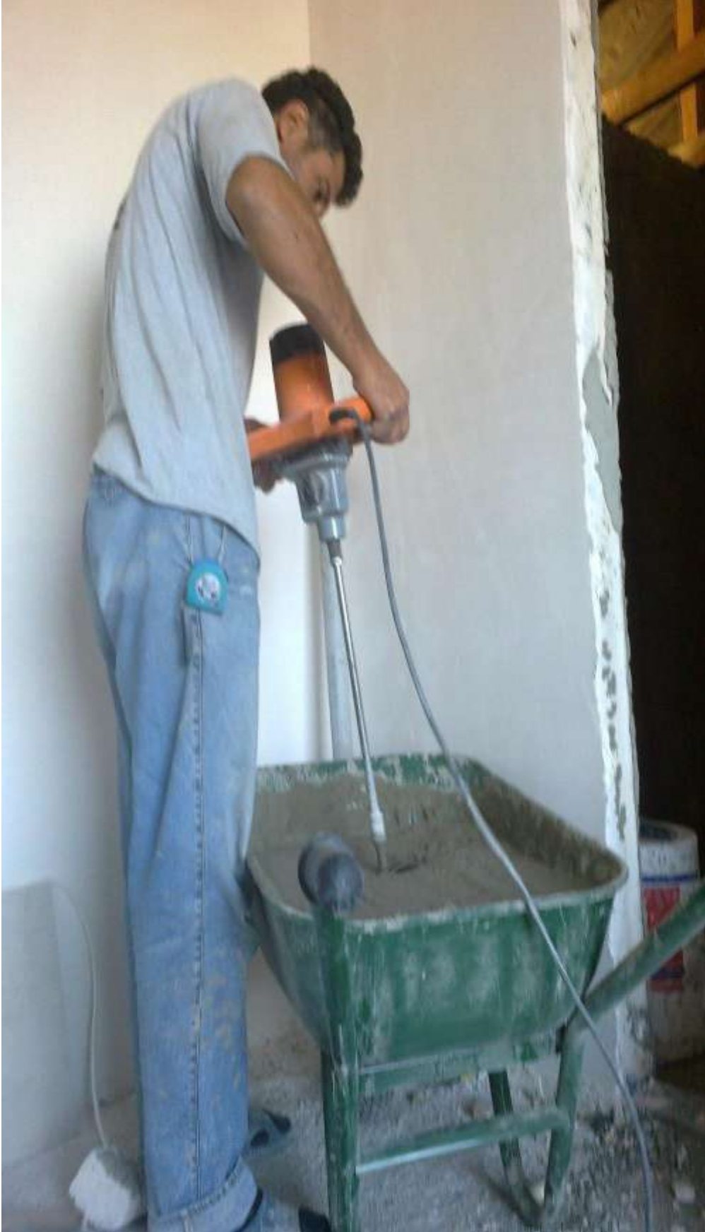
gekil-13 Fayans harcının hazırlanması
