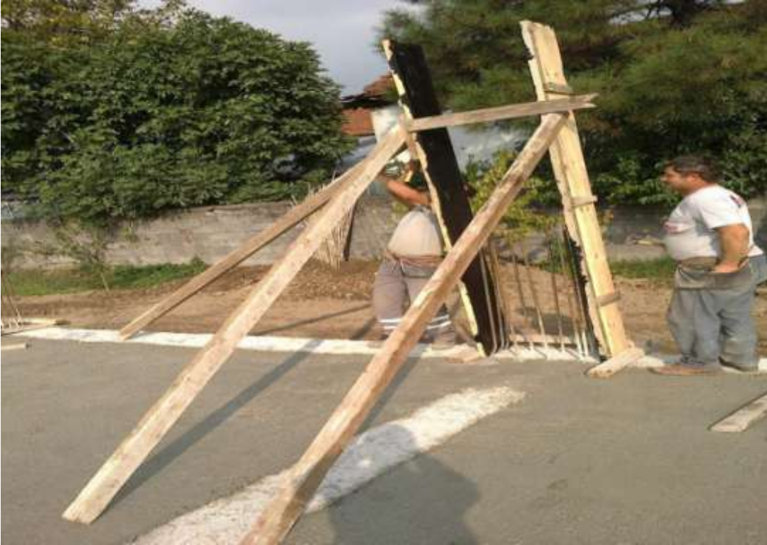
ğekil-69 Kolon yanaklarına destek yapımı
