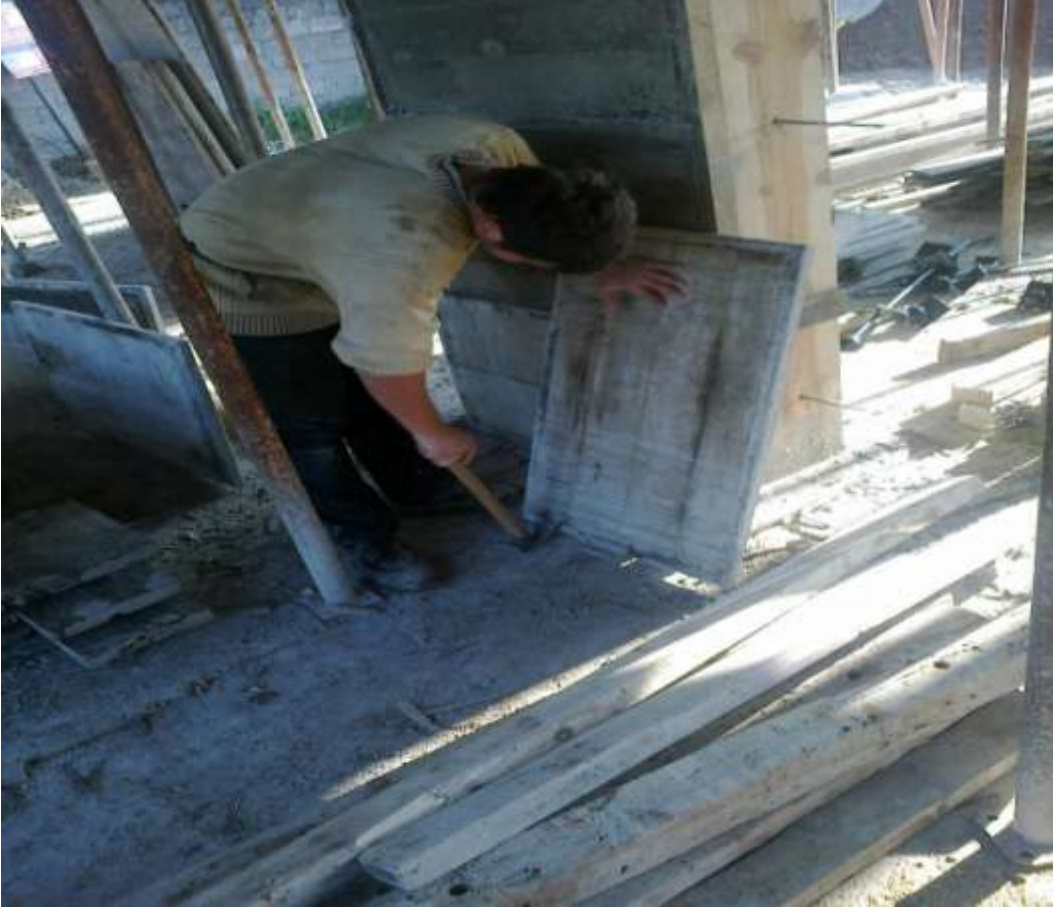
ğekil-80 Kalıp temizlenmesi
