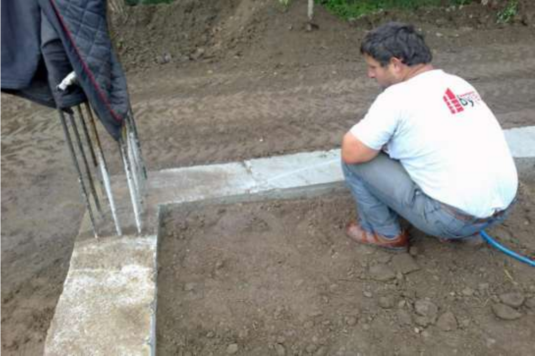
ğekil-84 Betonun sulanması
