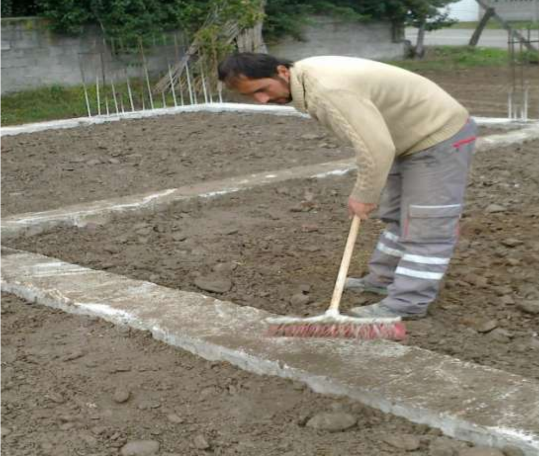
ğekil-83 Betonun temizlenmesi
